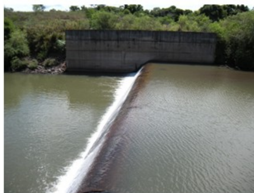
Captação - Trecho de desvio do Rio Pardinho
