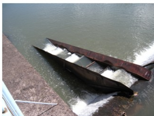
Captação - Escada de acesso de peixes
